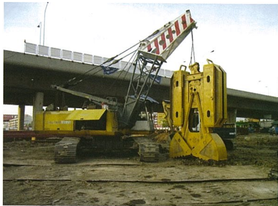
รูปที่ 5 กำแพง Diaphragm Wall (D-Wall)
