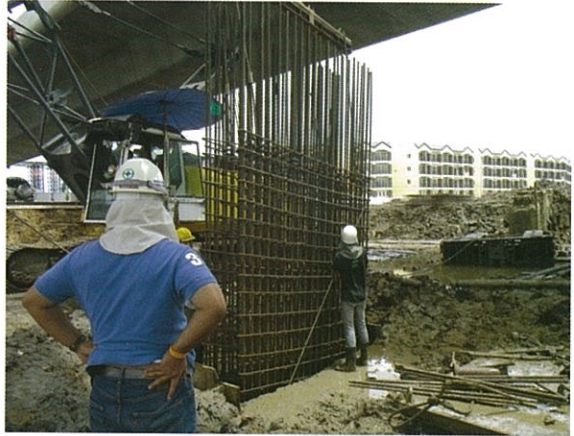
รูปที่ 5 กำแพง Diaphragm Wall (D-Wall)
