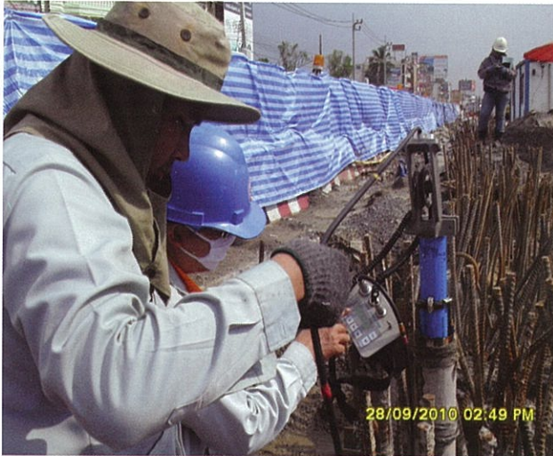
รูปที่ 13 การตรวจวัดเครื่องมือวัดการเคลื่อนตัวของกำแพงกันดิน
