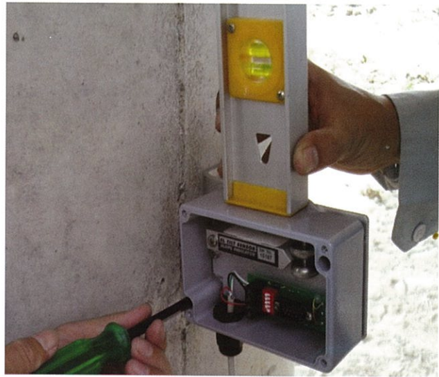
รูปที่ 15 การติดตั้ง Tiltmeter
