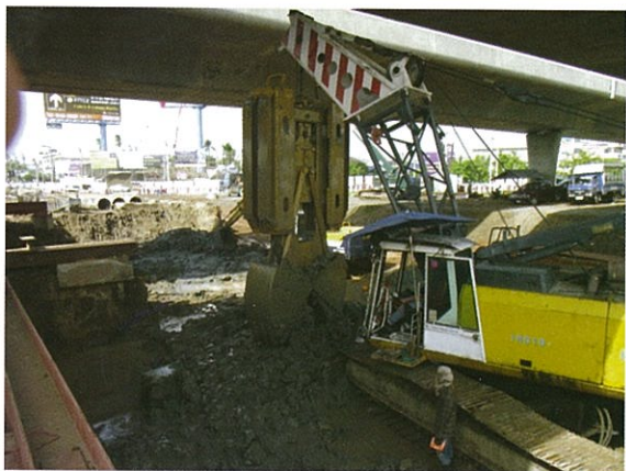
รูปที่ 6 เครื่องจักรที่ใช้ในการก่อสร้าง D-Wall
